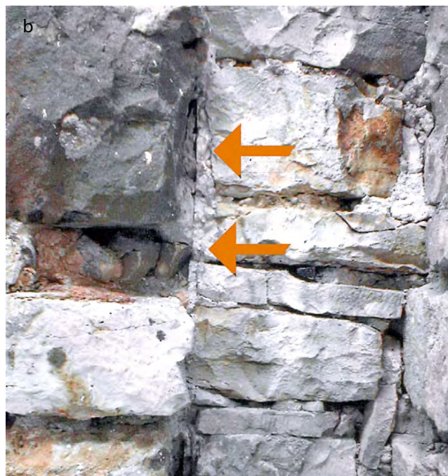
31. Istražno sondiranje, a) sonda na zidu u unutrašnjosti apside: 1. kamena građa zida, 2. prvi sloj žbuke, 3. nalič na prvom sloju, 4. drugi sloj žbuke, 5. dva ili tri sloja naliča; b) sonda na spoju zida priprate i jugozapadne lezene na pročelju crkve; c) unutrašnjost apside s konzerviranim i prezentiranim fragmentima izvorne pokrovne žbuke
